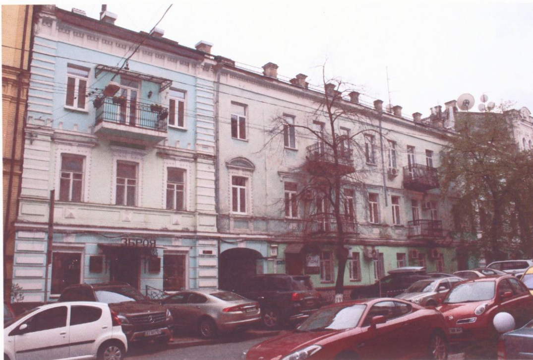
Вул. Ігорівська, 12. Будинок Житловий. Загальний вигляд будинку з боку вулиці. Головний (північний) фасад. Фото К. Денисова 2014 р.
