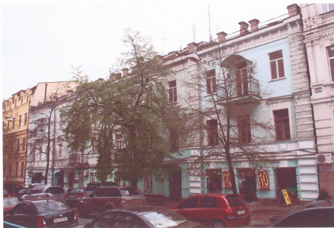
Вул. Ігорівська, 12. Будинок Житловий. Загальний вигляд будинку з боку вулиці. Головний (північний) фасад. Вигляд з заходу. Фото К. Денисова 2014 р.
