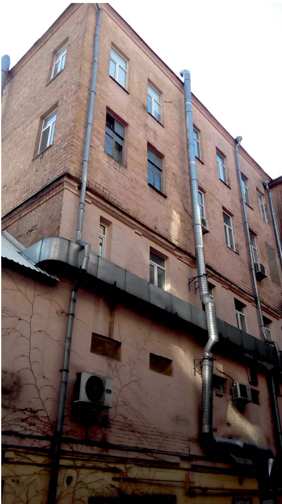
Дворовий фасад (фрагмент)
