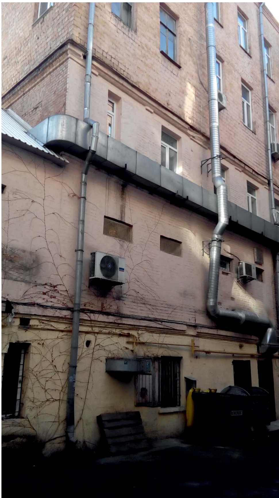
Дворовий фасад (фрагмент)
