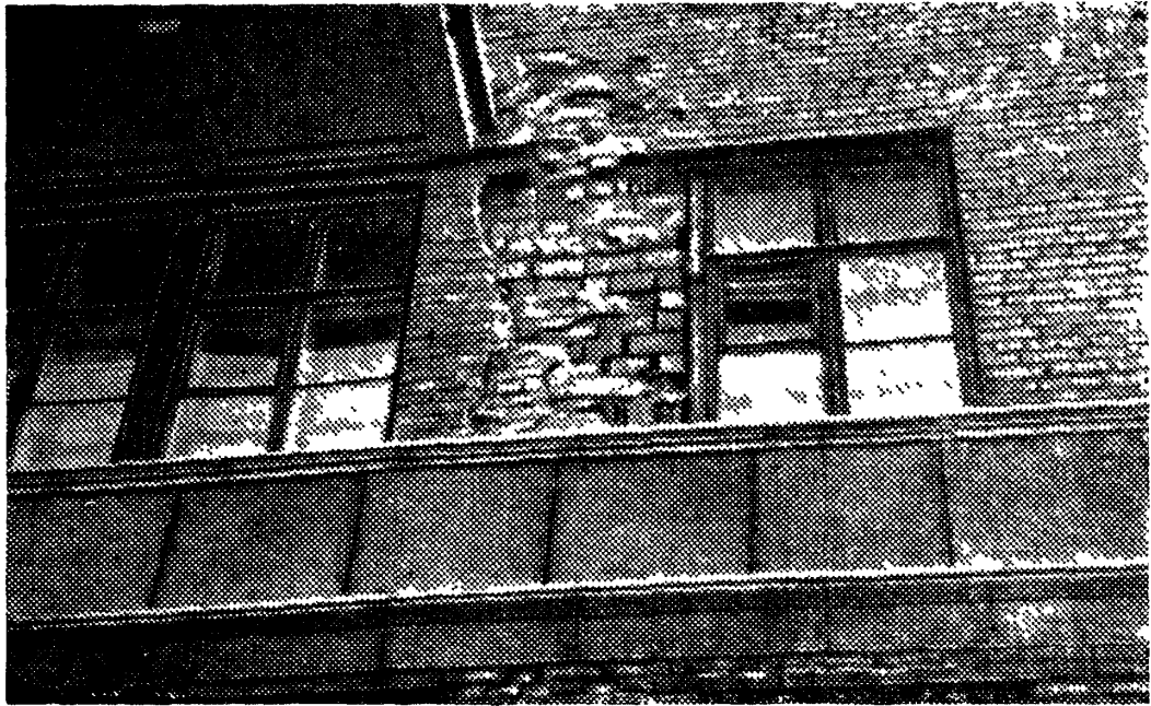
Рис. 7. Обрушение облицовки простенка, выполненного из силикатного кирпича
