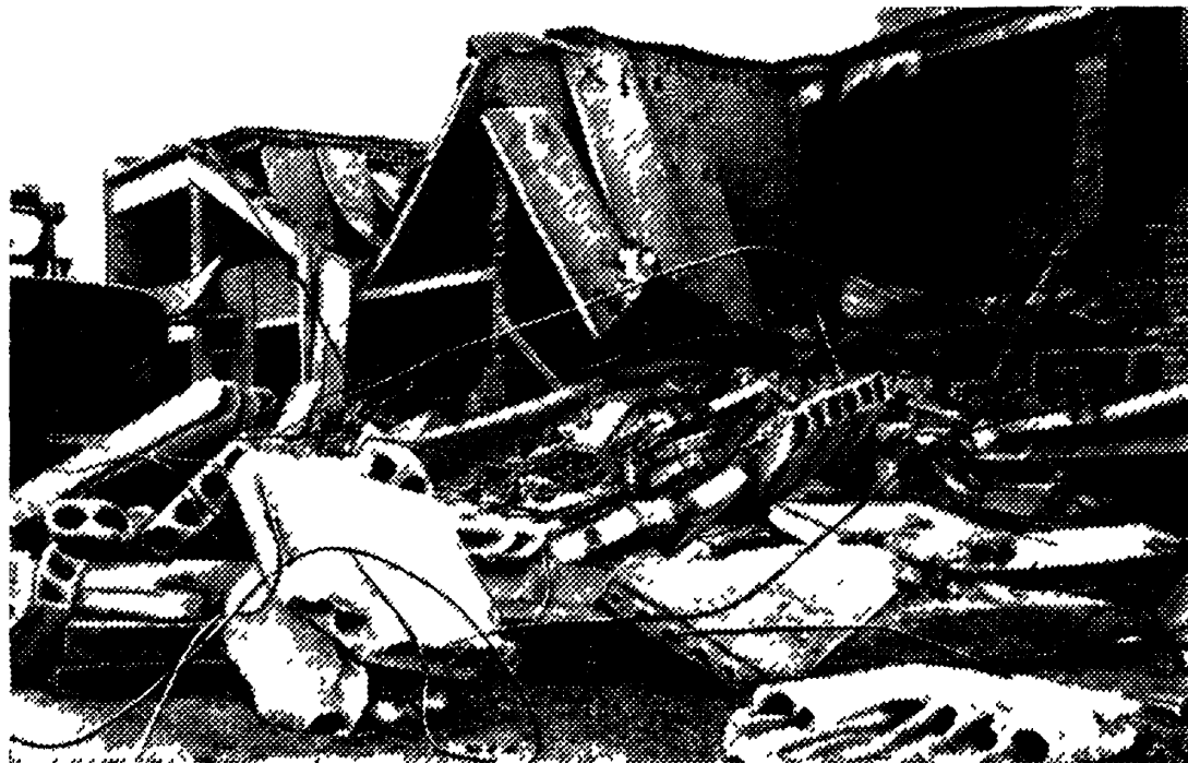
Рис. 36. Обрушение, вызванное недостаточным опиранием ригелей на кирпичные столбы
