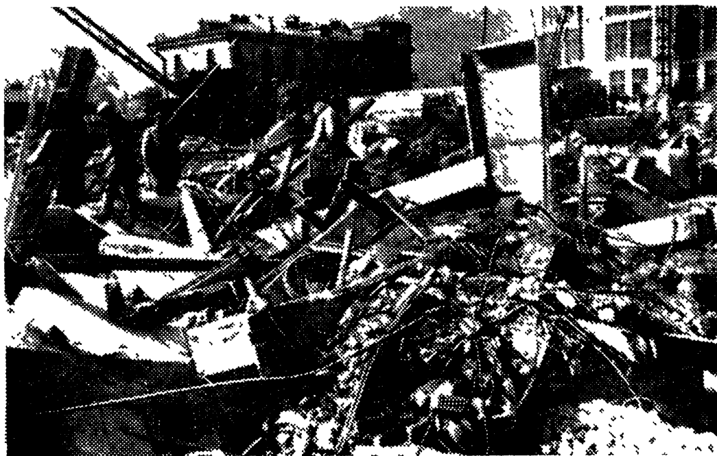
Рис. 41. Вид участка разрушенных конструкций монтируемого корпуса
