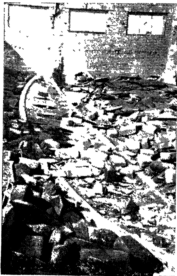
Рис. 34. Срез кирпичной кладки в пилястре
