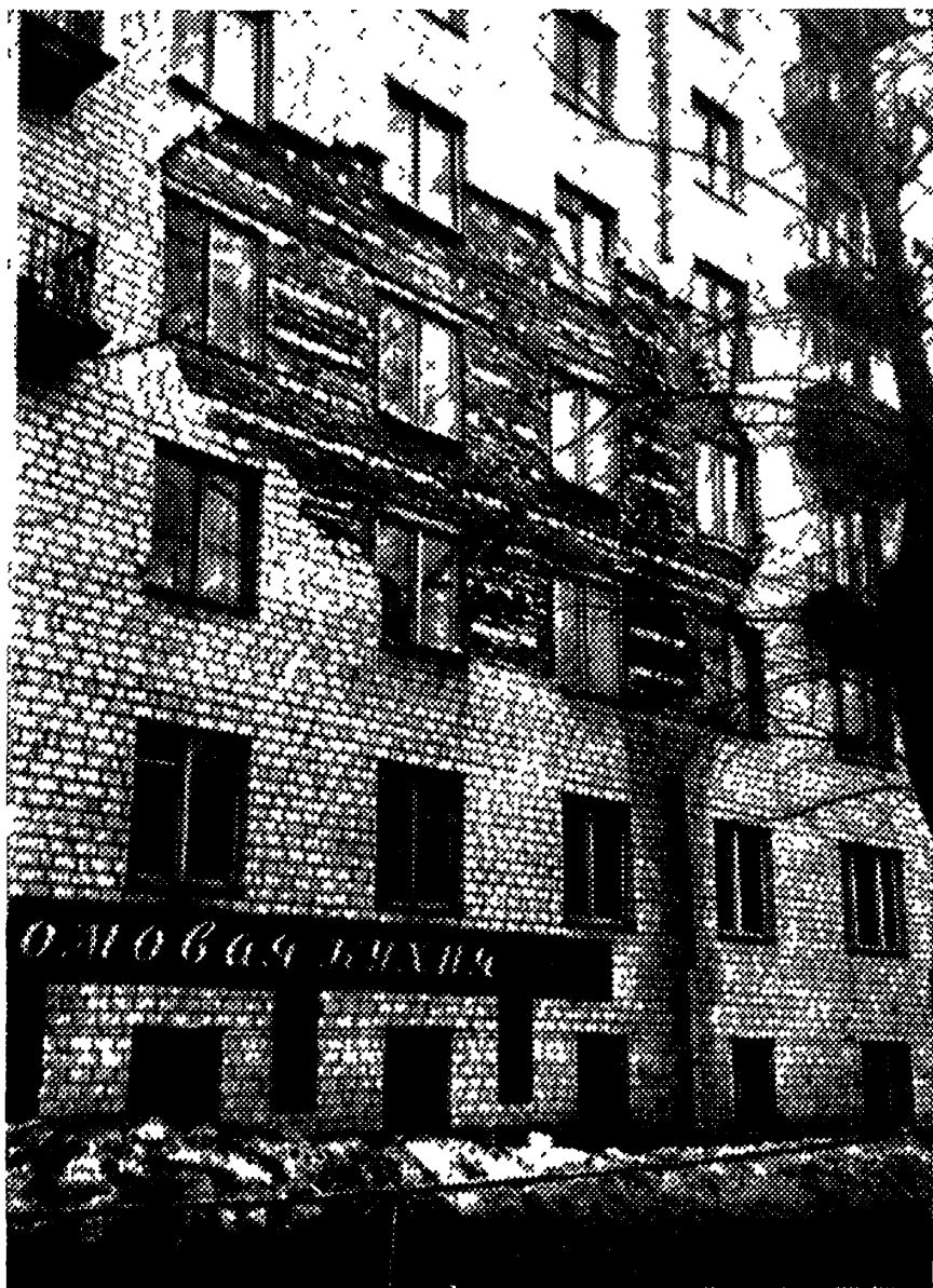
Рис. 9. Срез облицовки стен из семищелевых камней на фасадах зданий
