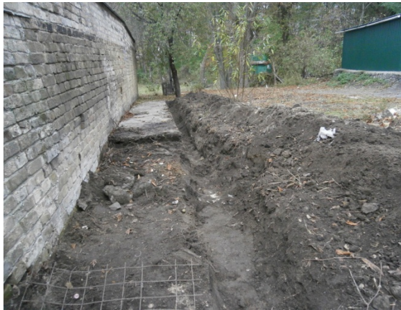
До проведення робіт
