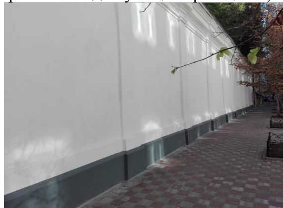
Стан після проведення робіт. Мури з боку вулиці Стрілецької
