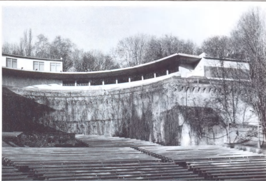
207.3.10. Підпірна верхня стіна. Паркова дорога, 2.
