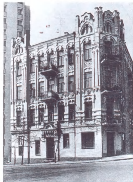
81.4. Вул. О. Гончара, 50.
