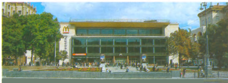
209.6. Станція метро «Хрещатик». Вул. Хрещатик.
