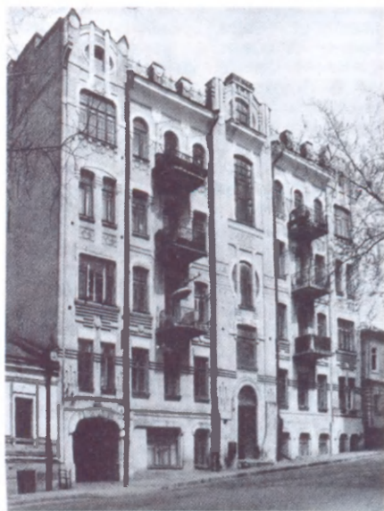
81.3. Вул. О. Гончара, 40.
