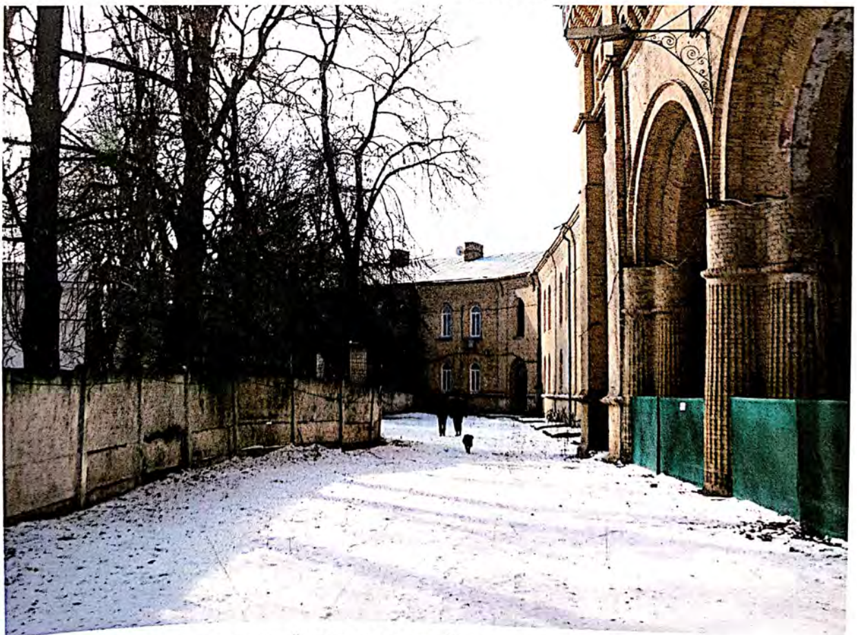
Фото 7. Фрагмент аркового проїзду в центральній частині східного фасаду будівлі казарми. Виз з північного сходу
