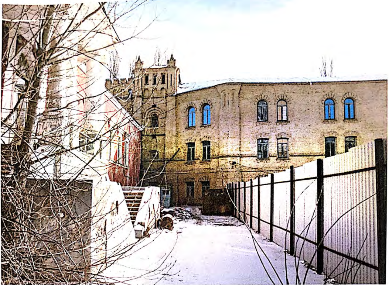
Фото 2. Фрагмент головного (західного) фасаду брами із заходу, з боку будівлі колишнього клубу (кофра)
