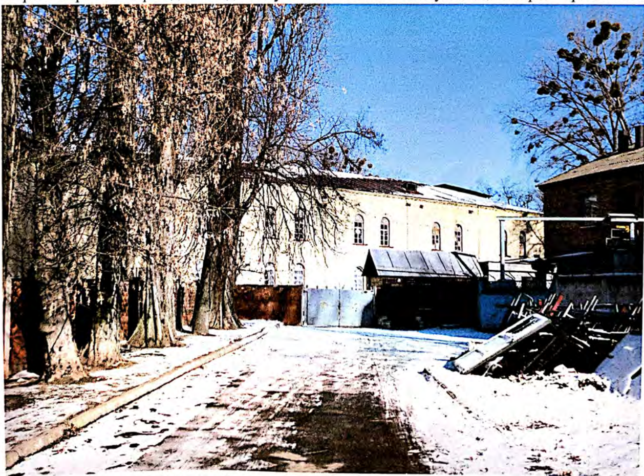
Фото 11. Північна частина східного фасаду будівлі казарми, службові та господарські будівлі, розташовані уздовж північно східної межі території пам'ятки
