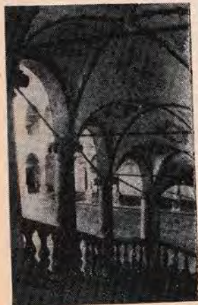
Лестница со двора ведет на лоджии 2-го этажа
