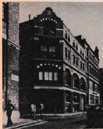
Вид на здание по Драйден-стрит, 5 со стороны Арне-стрит. Угловое окно на 1-м этаже ранее было двойными деревянными дверями. Загрузочные двери и лебедки на 2-м и 3-м этажах сохранены. Остекление на уровне пешеходного тротуара заменило прежние чугунные решетки, закрывавшие окна конюшни
