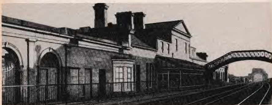
Вид станции со стороны платформы с новой стеклянной пристройкой
