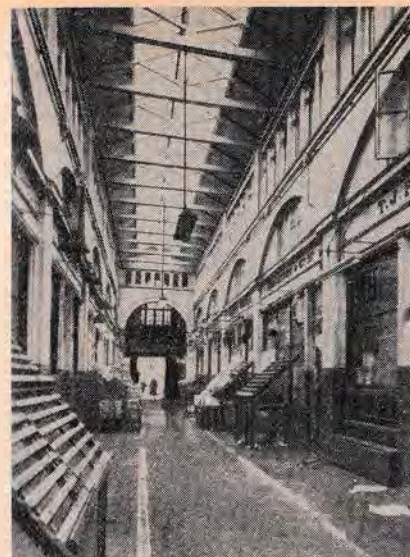
Центральный пассаж до реконструкции
