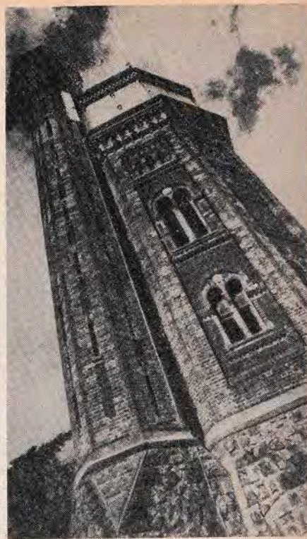
Деталь башни с винтовой лестницей водонапорной башни в Эплтоне
