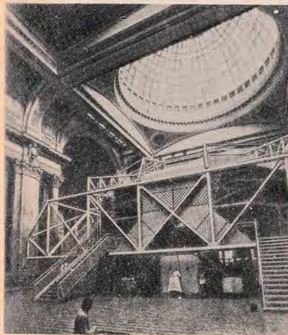
Легкий трубчатый навес над входом позволяет опознать новый театр и являет собой резкий контраст монументальному portalу
