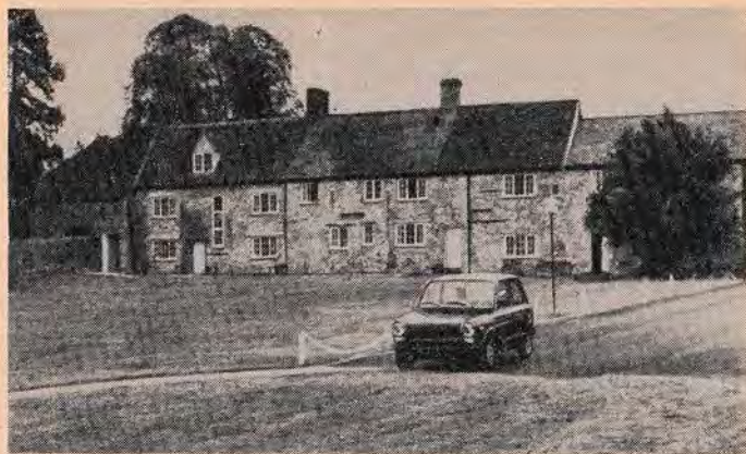
Задний фасад зданий по Хан- тер-стрит
