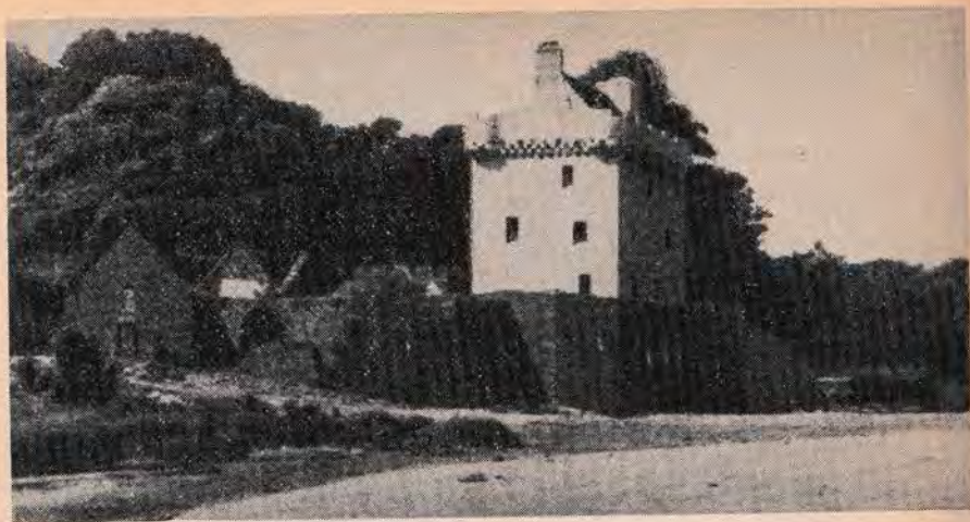
Вид с южной стороны
