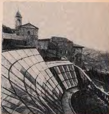
Верхний свет над группой лекционных помещений, садик на крыше
