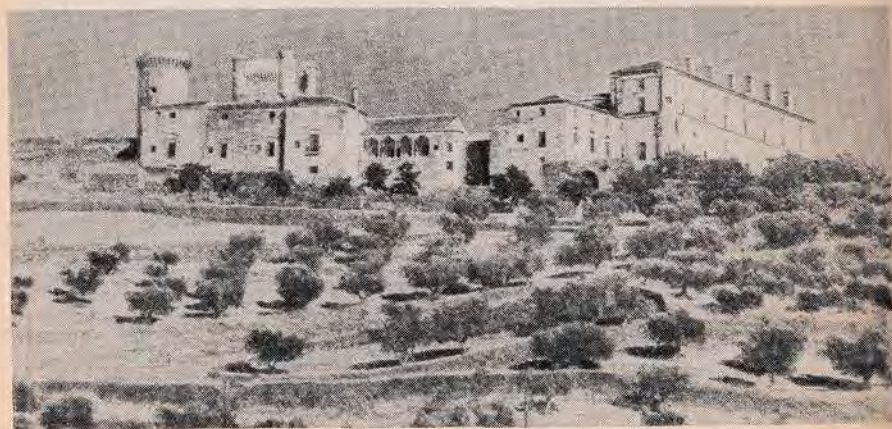
Оропеса, вид с западной стороны. Слева — замок, справа — графский дворец, ныне перестроенный в парадор
