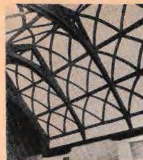
Конструкции деревянного перекрытия над залом на 2-м этаже
