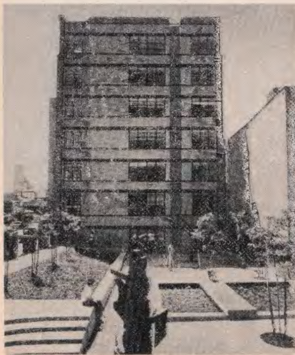
Северо-восточный фасад — новый. Здание, примыкавшее к фабрике с этой стороны, снесено, и на его месте разбит сквер и устроен вход
