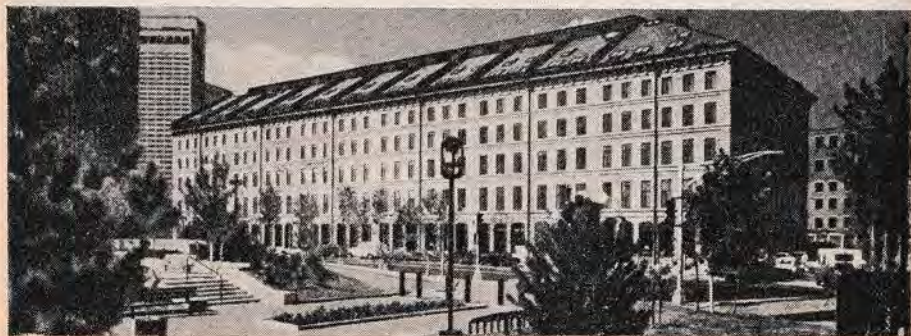
Вид со сторо- ны обществен- ного парка на Атлантик аве- ню. Здание бы- ло наполовину длиннее до проведения ав- тострады в 50-х годах
