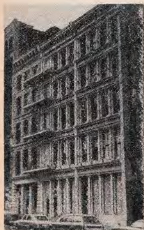
Уличный фасад цугунных складов
