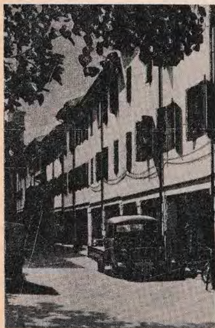
Разборка стен у ворот Кастильоне
