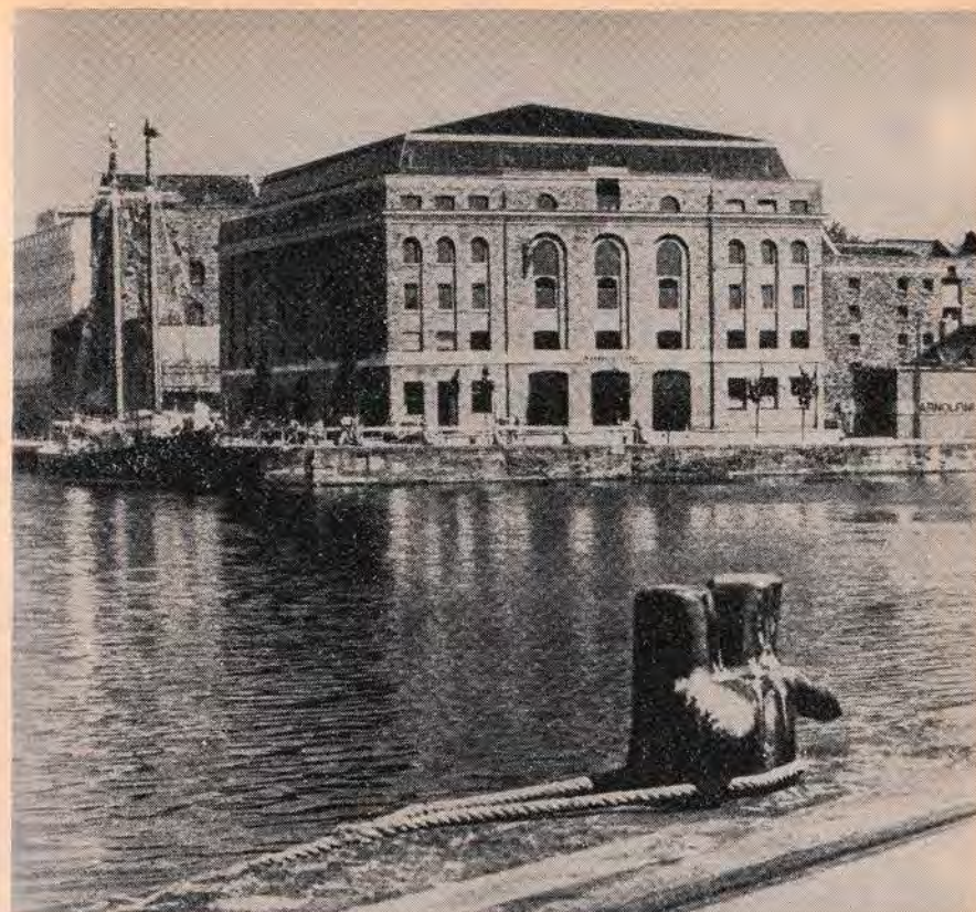
Склады Буша после перестройки, видна новая крыша
