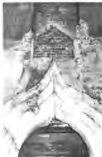
60. Вид из раскопа Коломенское, церковь св. Михаила. Слой обшивки интерьерной стены подвалов
