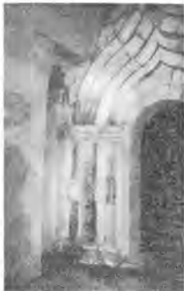
30. Риз. Очистка и реставрация фасада здания в Риге. Применение контрастных материалов для обозначения новых элементов
