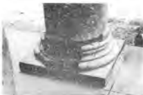
30. Риз. Очистка и реставрация фасада здания в Риге. Применение контрастных материалов для обозначения новых элементов
