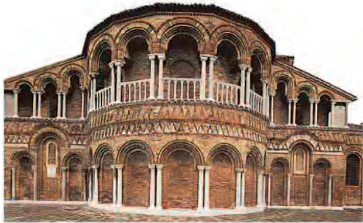
The colonnaded exterior of Murano's Basilica dei Santi Maria e Donato
